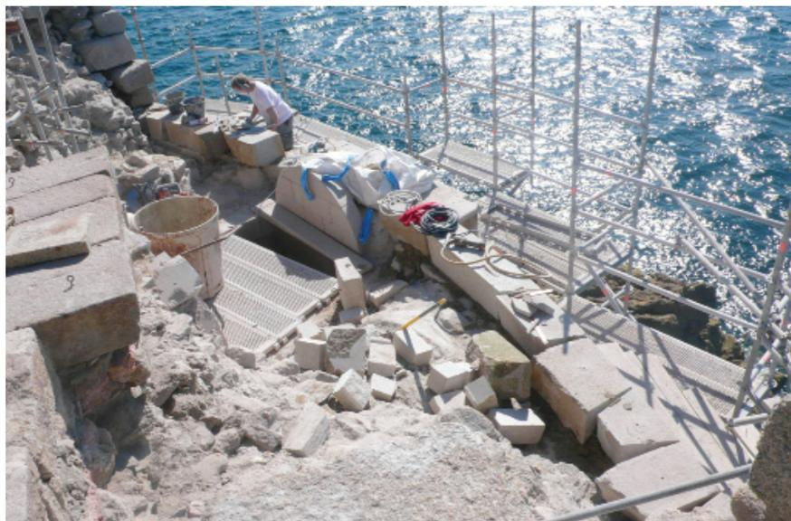
Le rempart s'élève rang après rang au-dessus du couloir d'accès. Des pierres en tout venant vont combler l'espace jusqu'au niveau de la plateforme sur la gauche.
